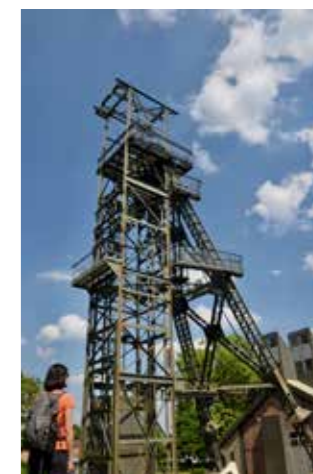
On traverse l'ancien pays minier, avec ses terrils, ses corons et ses chevalements de métal comme ici, celui de Marles.
