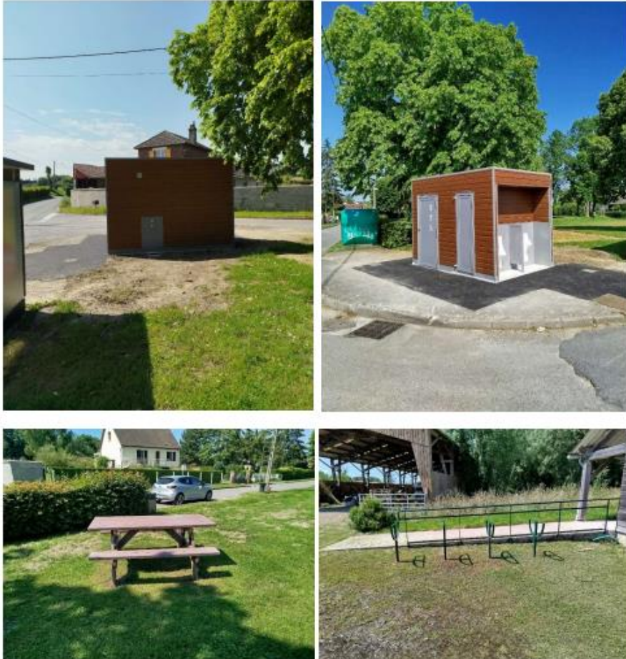
Aire de service complète – Saint Germer de Fly
